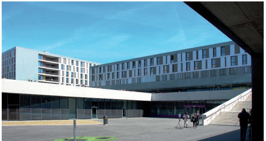
Farbkunst prägt lebendig die Aussenseite des Studenten-Unterkunftsgebäudes. Die Fassaden wechseln sich nach aussen in einem regelmässigen Raster aus raumhohen Fenstern und dunkelgrauen Faserzementpaneelen von Eternit ab. (Bild: Eternit)
